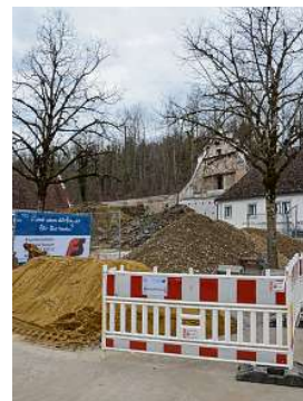
Die Schrote wird völlig neu aufgebaut und später als Multifunktionsgebäude genutzt.
