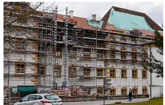
Am Hauptsitz in Salem wird in einer Größenordnung von 20 Millionen Euro investiert. Einige Bauarbeiten sind bereits erledigt. Im Frühjahr 2019 soll alles abgeschlossen sein.
